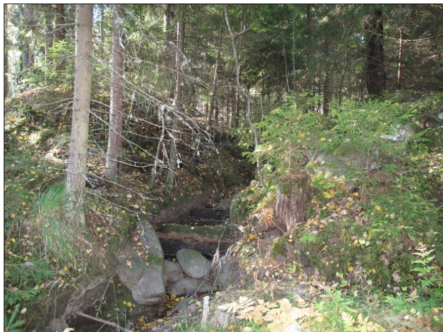
Hirsirakenne puron kohdalla.
