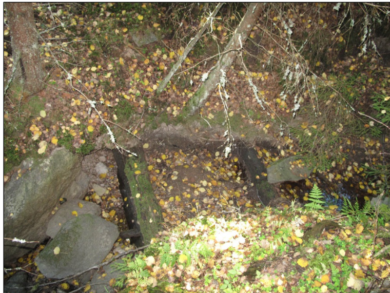
Hirsirakenteita puron kohdalla.
